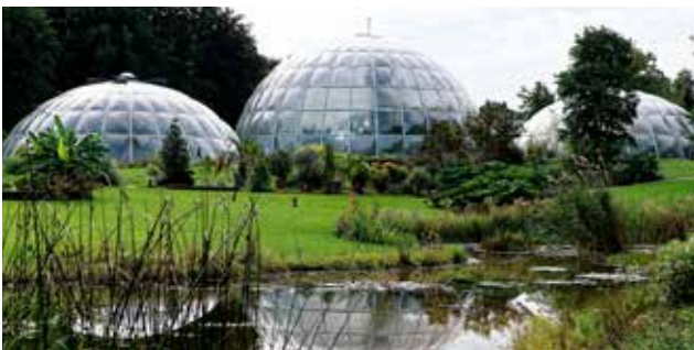
Kuppelgewächshäuser mit Teich vor der Sanierung 2013. Von links: Savanne, Tropen und Subtropen.
